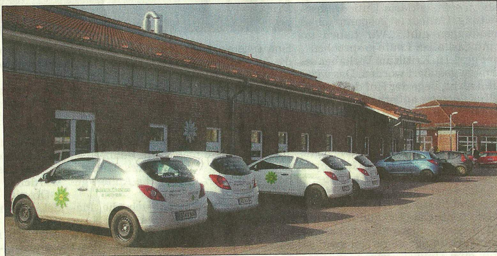
In den ehemaligen Aukruiger Aldi-Markt ist wieder Leben eingekehrt. Die Gemeinde investiert insgesamt 1,3 Millionen Euro in den Umbau zu einem Gesundheitszentrum.
